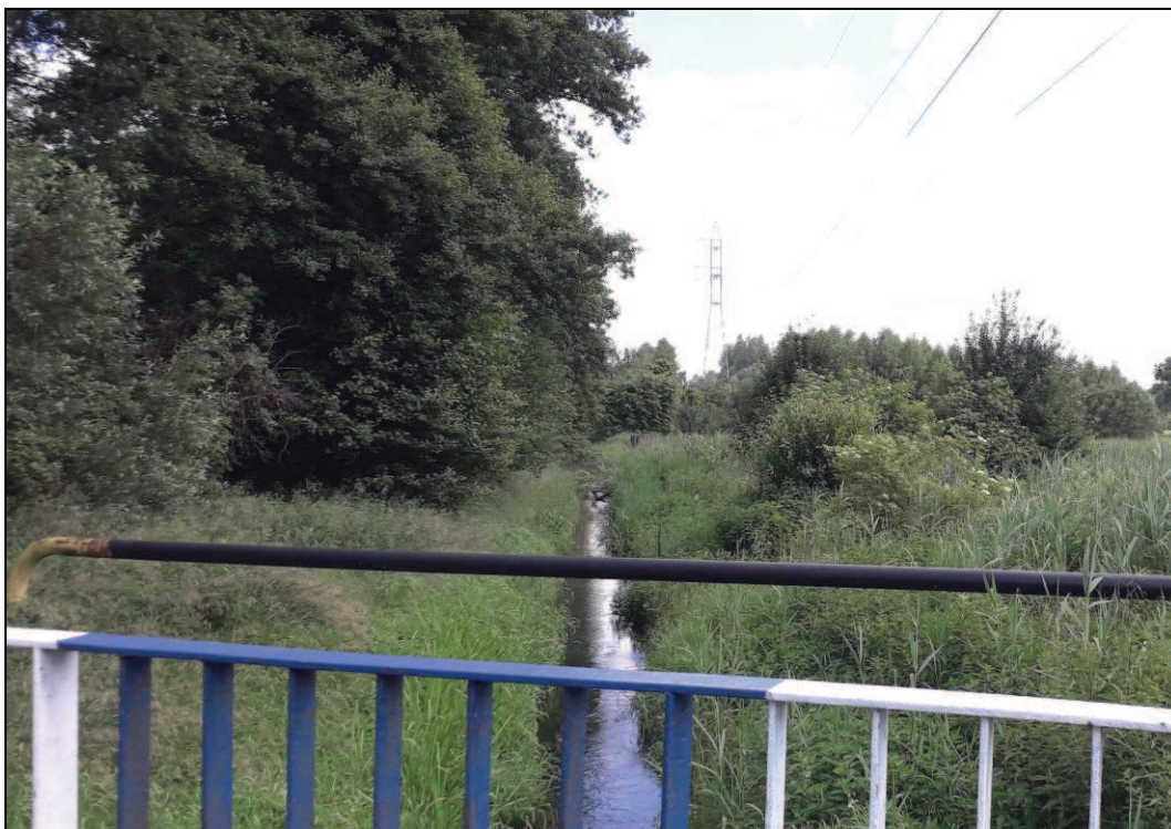
Fotografia 3. Koryto cieku Jaworznik widoczne z ul. Dąbrowskiej
